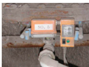
大口徑管道 彎曲部分的排水實例
